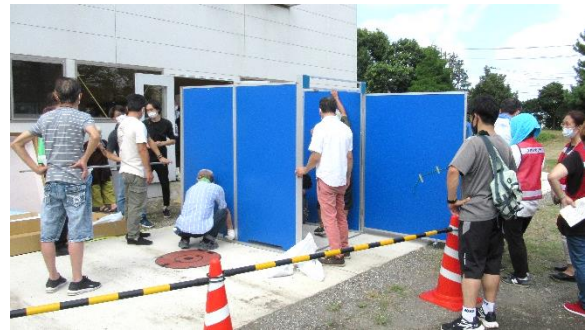
障がい者用トイレを組立てています。
